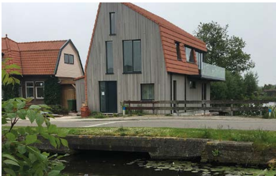
Een stuk beton is afgebroken.
