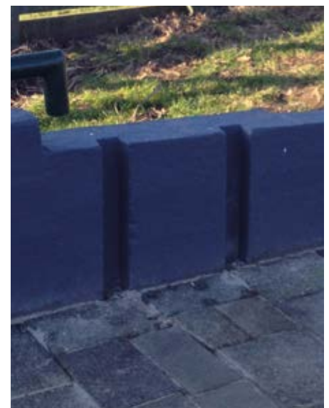
Sleuven in de brug over de ringsloot van de Googerpolder die het Westeinde in Roelofarendsveen met het Pastoor Onelplein verbindt. Een waterkering op de brug?
