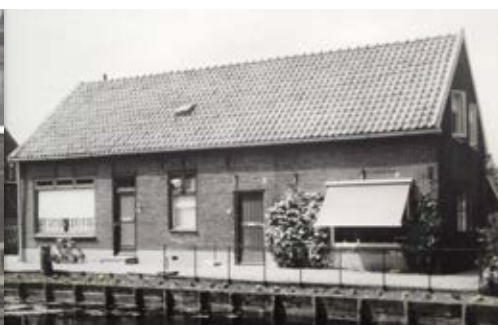
Het verbouwde dubbele woonhuis.
